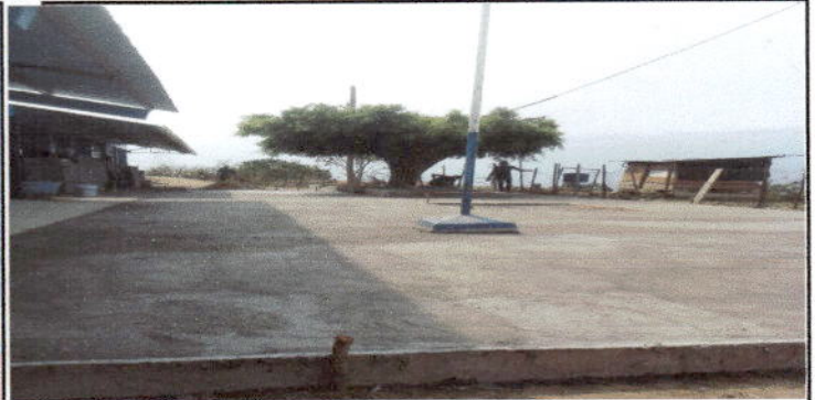
Foto 2: Piso puesto en el corredor de las aulas
