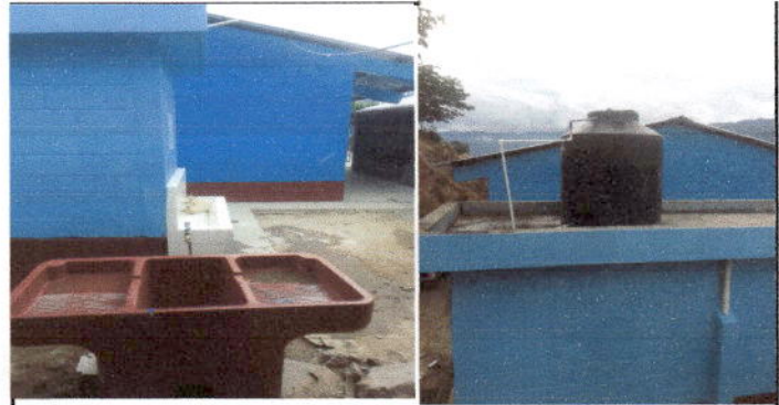
Foto 6: Pila, lavamanos, accesorios de baños y rotoplas colocadas satisfactoriamente.
