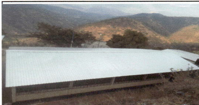
Foto 5: Cubierta de lámina finalizada de las aulas.
