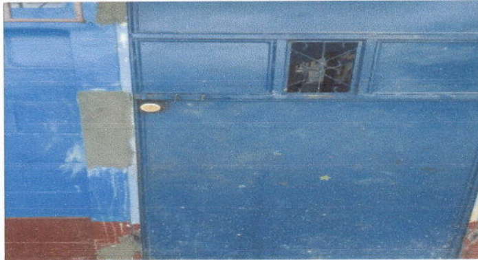
Foto 1: sustitucion de chapa
