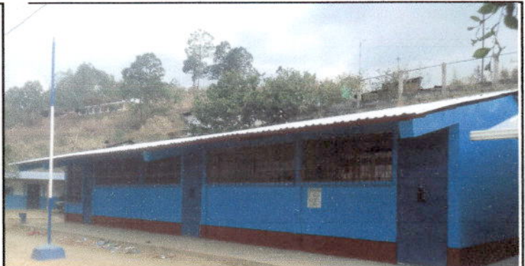
Foto 4: Pintada terminada satisfactoriamente
