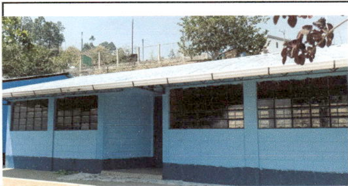
Foto 3: Colocación de los vidrios de las ventanas.
